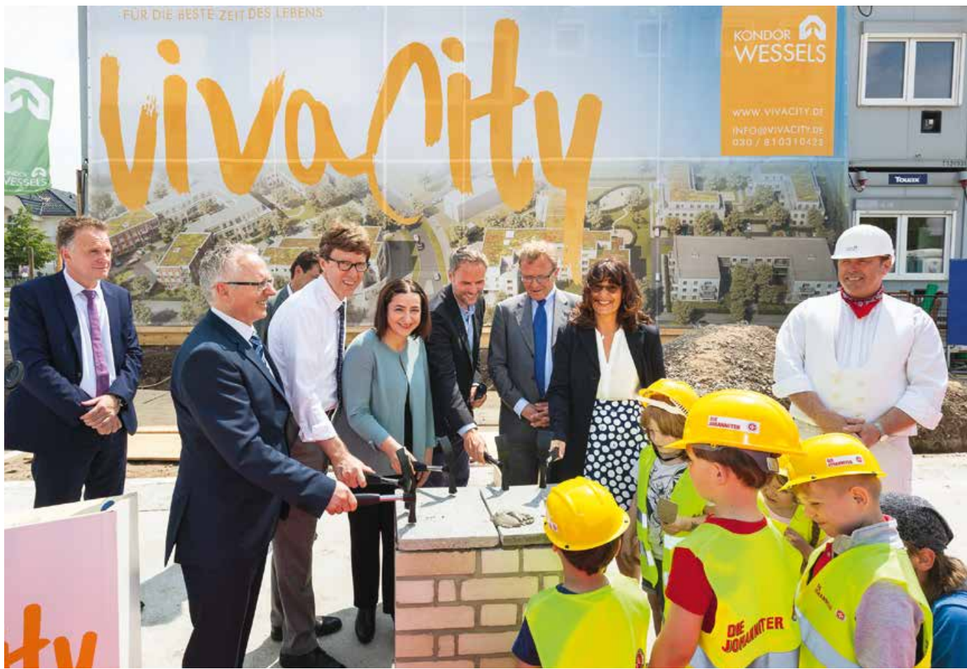
Grundsteinlegung für die VivaCity Adlershof am 31. Mai 2016 Laying of foundation stone for VivaCity Adlershof on May 31st 2016
