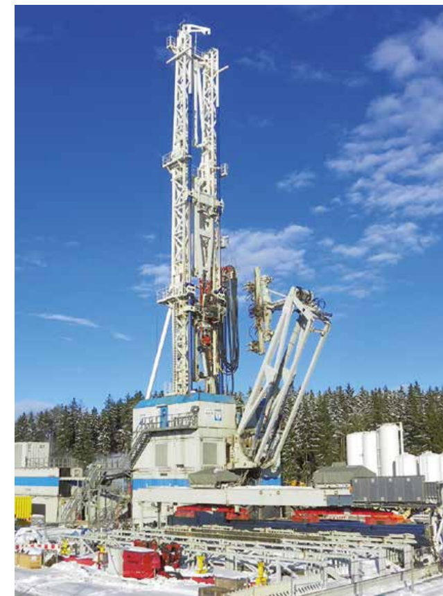
Start der Bohrung in Traunreut Drilling in Traunreut
