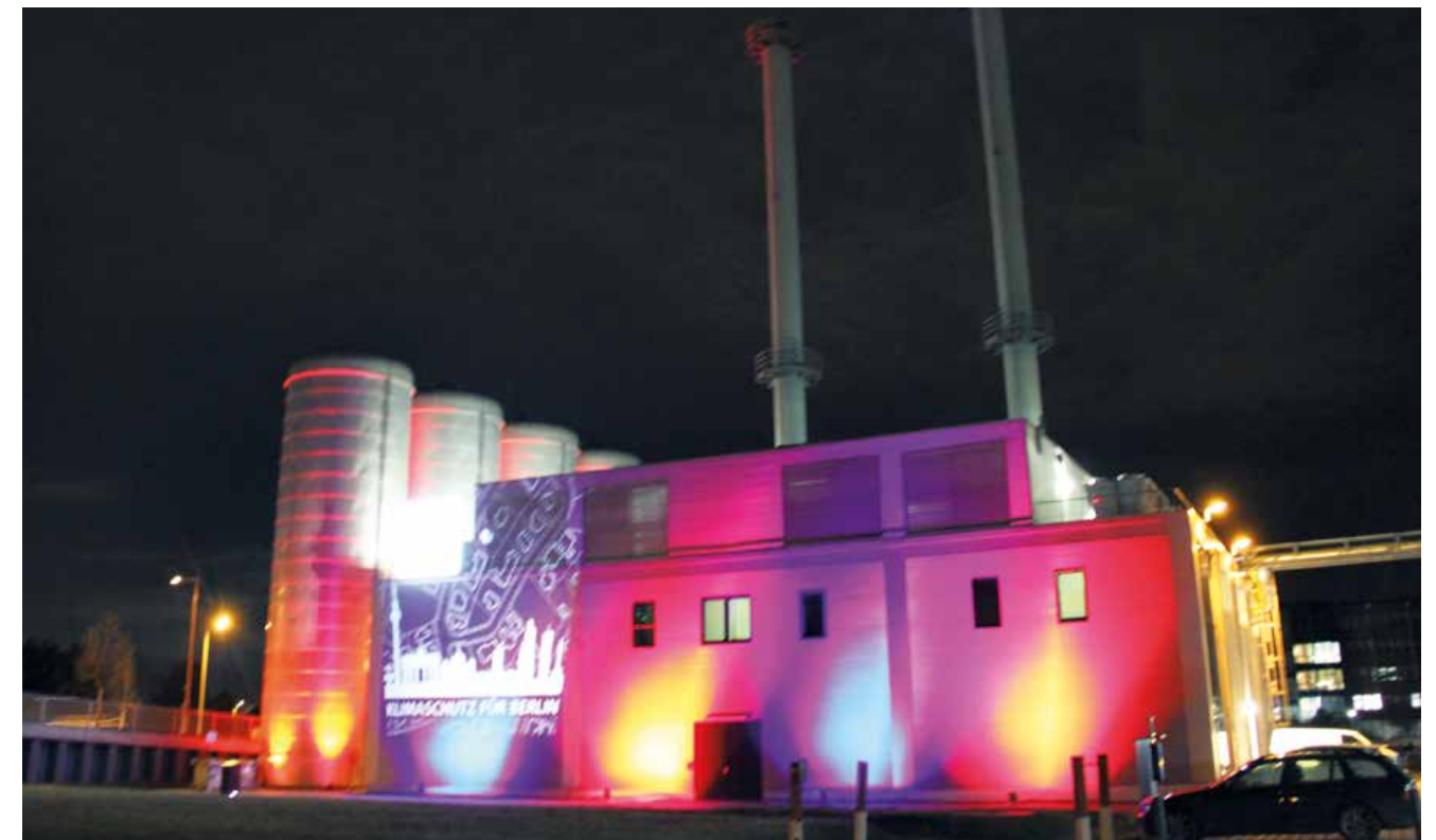
Beleuchtete Wassertanks des Heizkraftwerks Adlershof Illuminated BTB watertanks of the Power and Heat Supply Station Adlershof
