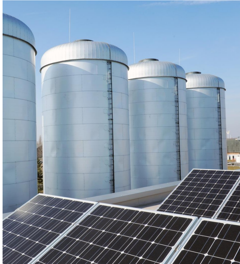
Wärmespeicher der BTB in Adlershof. Quelle Fotodatenbank WISTA
