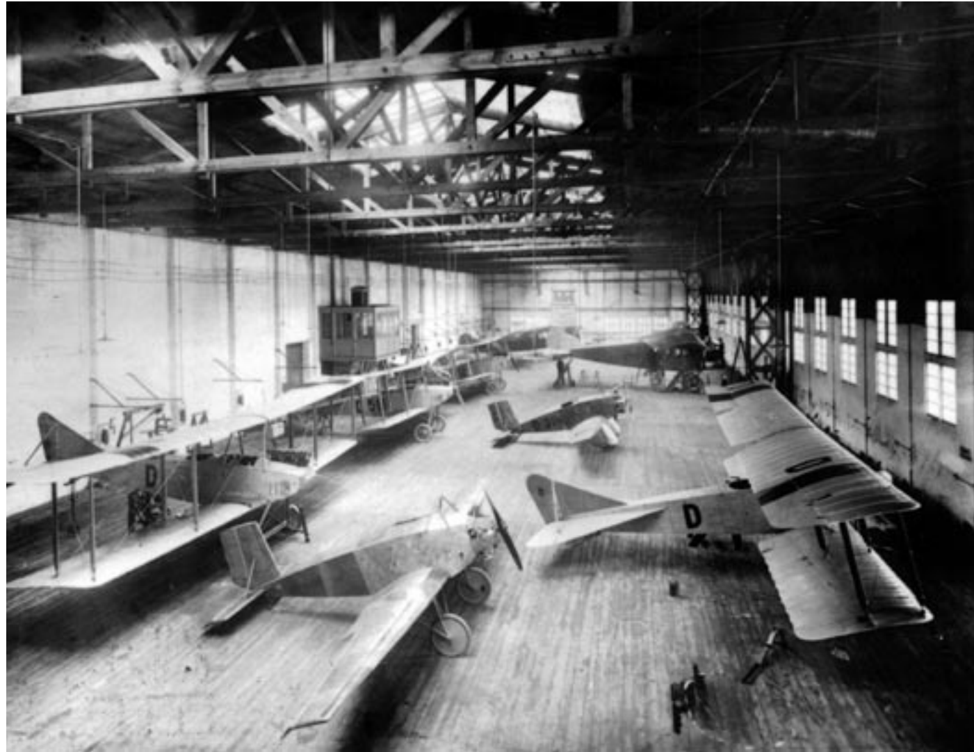
Foto der Montagehalle der Albatros-Werke um 1922/23. Umbauten aus ehemaligen Militärflugzeugen stehen nach Lockerung der Bestimmungen des Versailler Vertrages für eine zivile Verwendung zur Verfügung.
