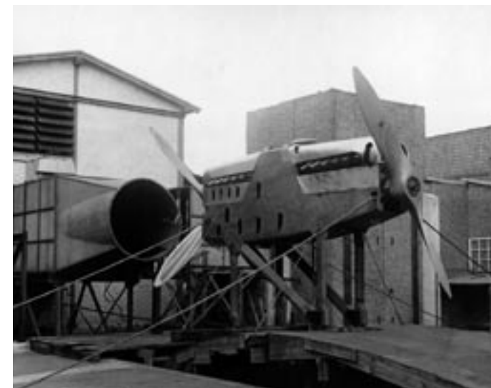
Tandem-Triebwerk eines Dornier-Flugbootes auf dem Motorenprüfstand.
