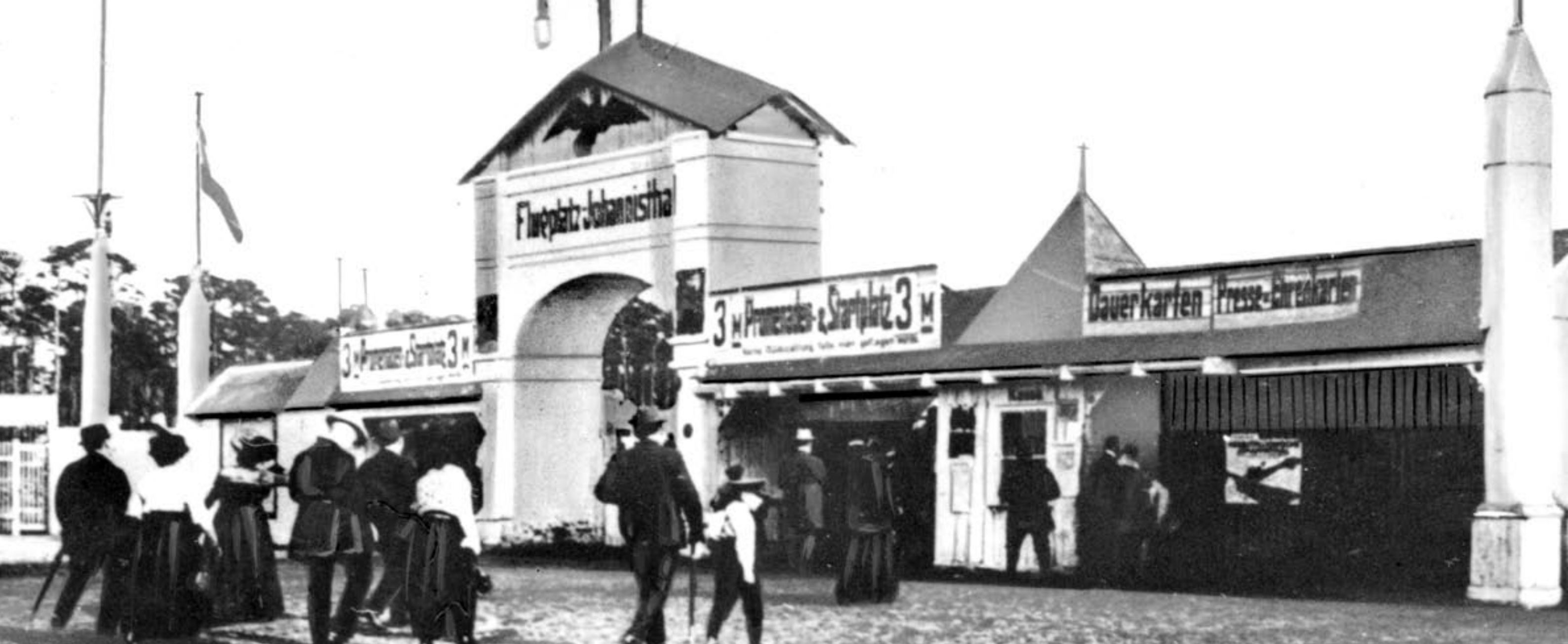
Haupteingang des Flugplatzes Johannisthal mit Kassenhäuschen, um 1912.
