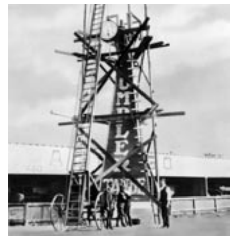
Arbeiten am Zeitnehmerturm für die Flugwettbewerbe.
