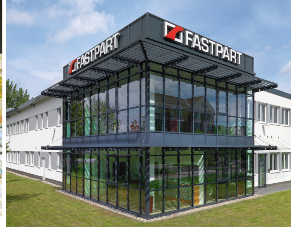
Die FASTPART Kunststofftechnik GmbH sitzt im CleantechPark Marzahn
