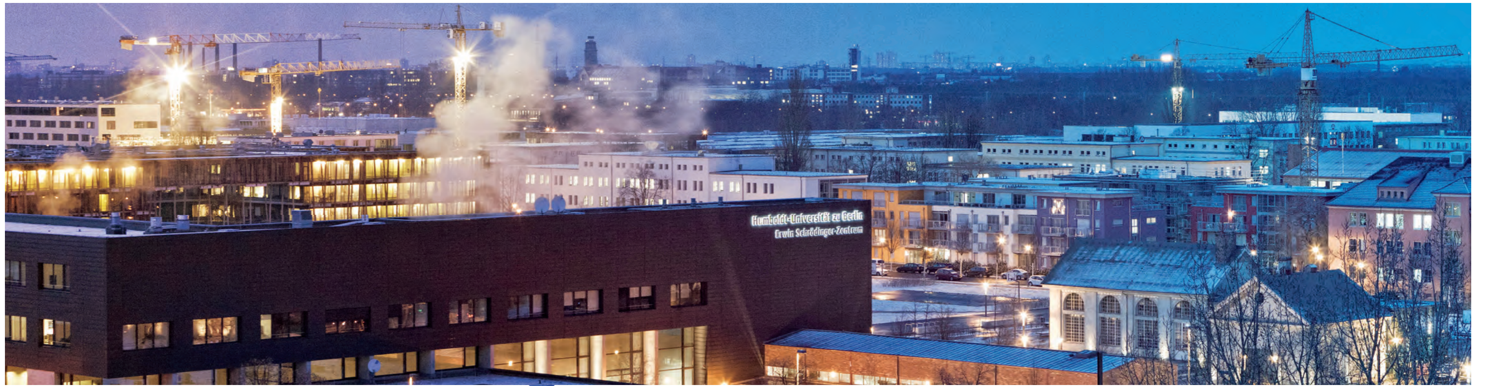
◆ Abendliches Panorama, das für sich selbst spricht: Kräne über dem Technologiepark Adlershof A twilight skyline that speaks for itself: tower cranes over the Technology Park Adlershof
