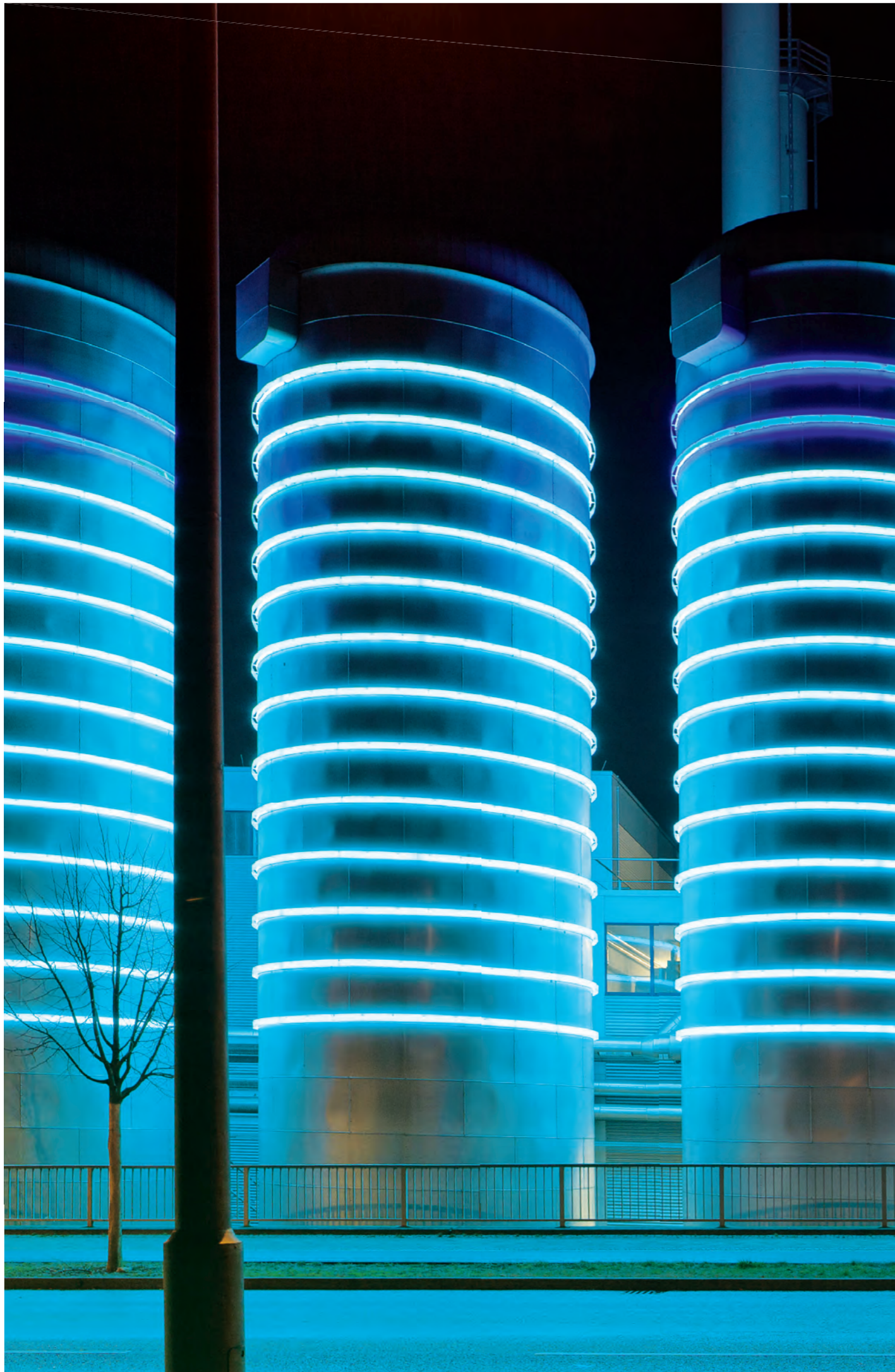
◆ Kunstwerk am Kraftwerk: Warmwasserspeicher der BTB Blockheizkraftwerks-Träger- und Betreibergesellschaft mbH Berlin in Adlershof Works of art: the illuminated hot water supply tanks of BTB Blockheizkraftwerks-Träger- und Betreibergesellschaft mbH Berlin in Adlershof
